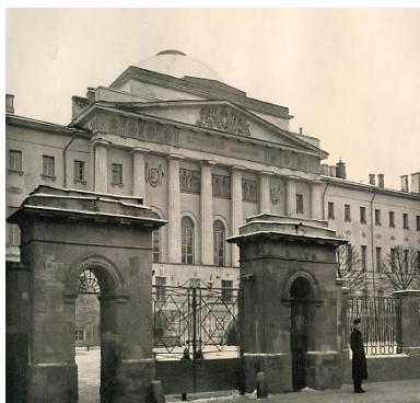
Здание Императорского Московского университета 1900 –1903 годы
